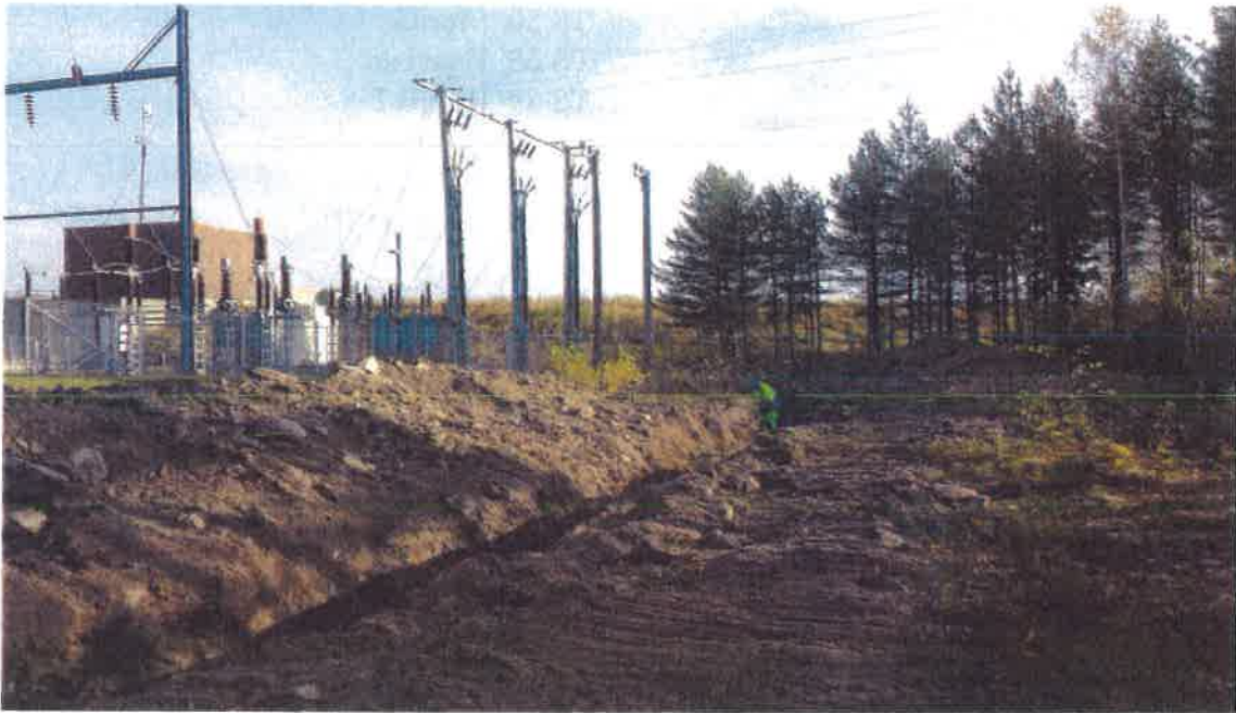
Jordkabelgrävning vid Kaitfors kraftverk - Maakaapelointi Kaitforsin voimalaitoksella
