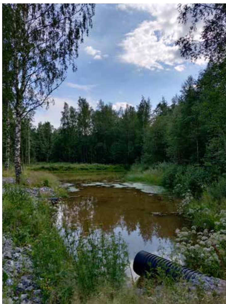
Dagvattenbassängen på Fabriksgatan i Jakobstad är anlagd för att förebygga översvämningar vid hårda skyfall.
