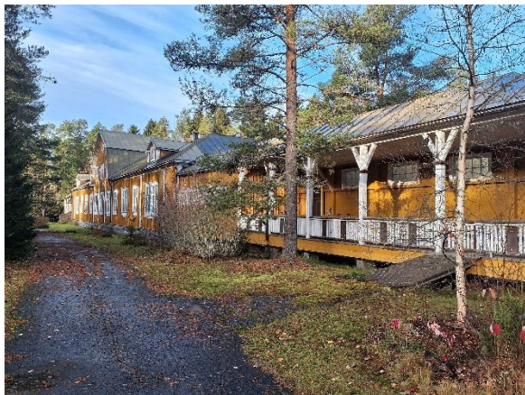
Byggnadens södra sida med terrasser
