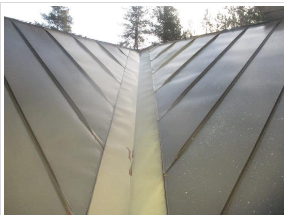
Vattentaket av falsad plåt
