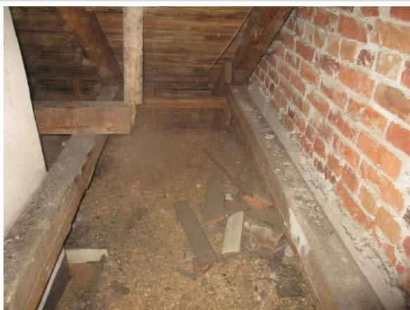
Övre bjälklag med spånisolering och brandmuren
