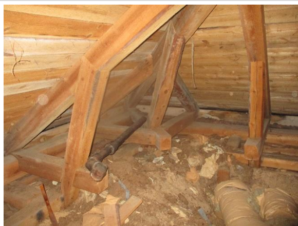
Övre bjälklag med lera, mossa och torv som isolering
