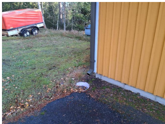
Stuprör på västra sidan
