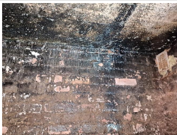
Bitumenstrykning på väggen och betongvalvet
