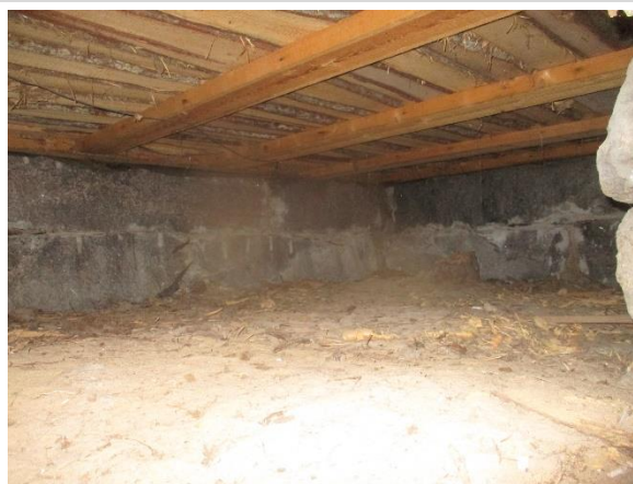
Inga synliga mikrob- eller rötskador på golvbjälklaget
