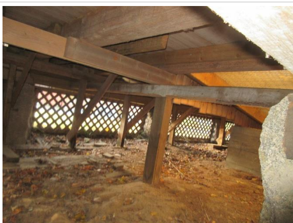
Terrassens golvbjälklag och kryppgrund
