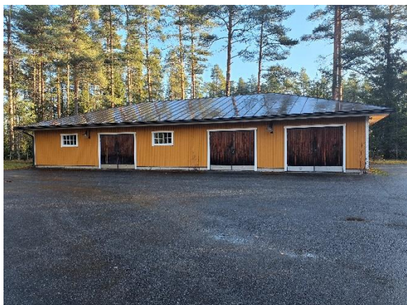
Översiktsbild av garaget
