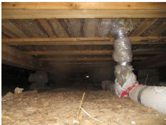
Förnyade avloppsrör isolerade i kryppgrunden
