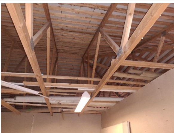
Inga spår av takläckage noterades
